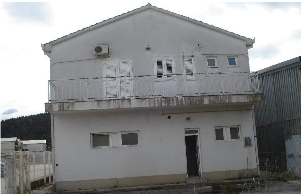
Slika 18. Stražnja strana upravne zgrade
