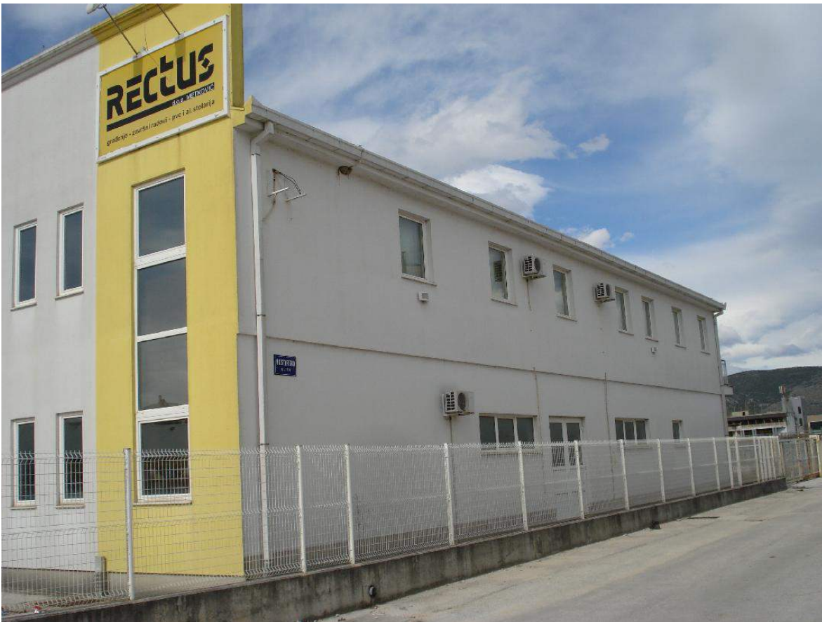
Slika 17. Upravna zgrada s bočne strane
