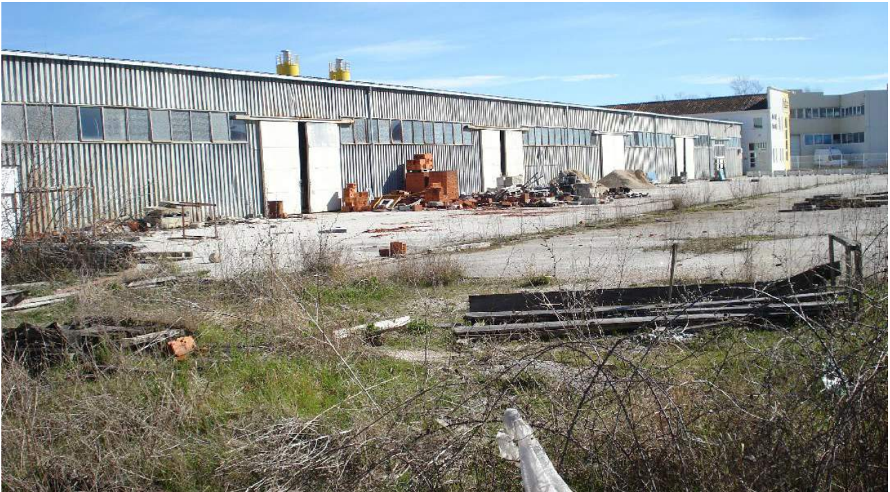
Slika 15. Vanjski izgled hale
