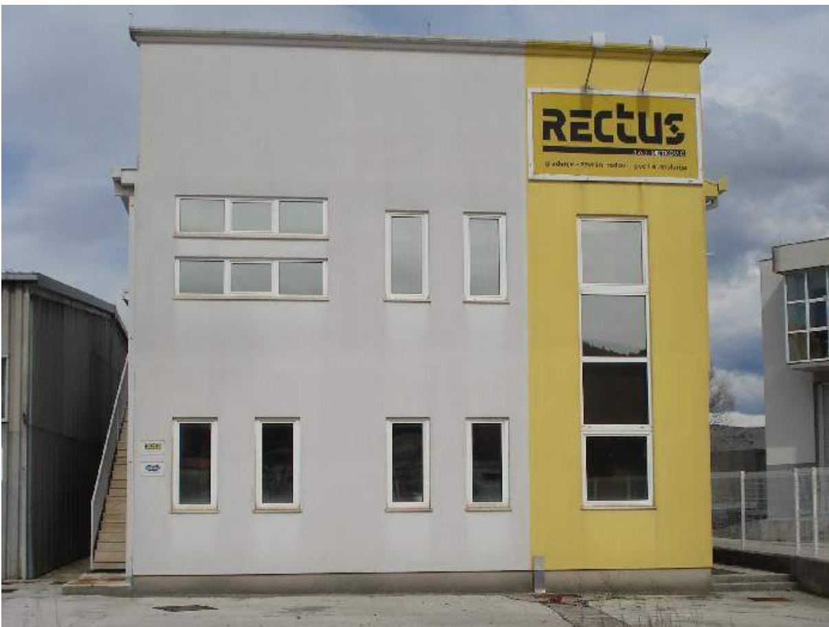
Slika 16. Prednja strana upravne zgrade
